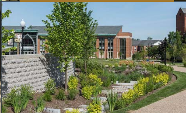
Bioswales & Porous Pavement
